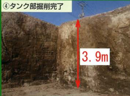
③ タンク部掘削完了
