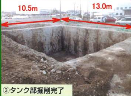
④ タンク部掘削完了
