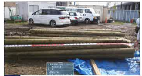
03 丸太杭搬入計測
