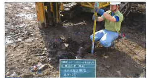
09 打設完了レベル測定
