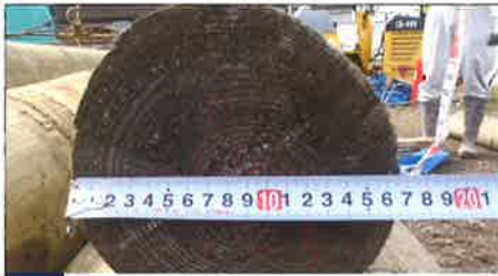
04 丸太杭搬入計測
