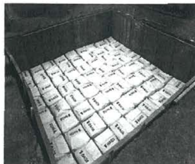
T-BAGS敷込み完了
