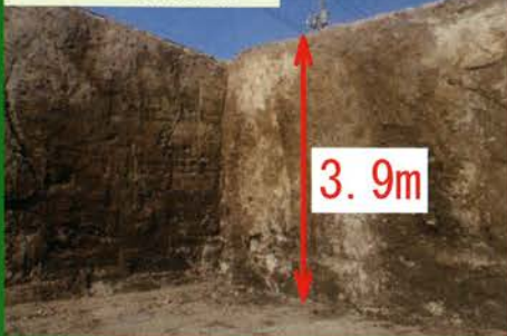
④ タンク部掘削完了
