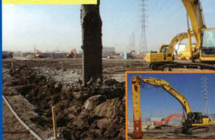
③掘削・底盤改良
