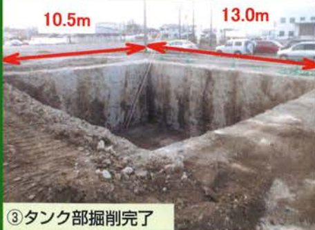
④ タンク部掘削完了
