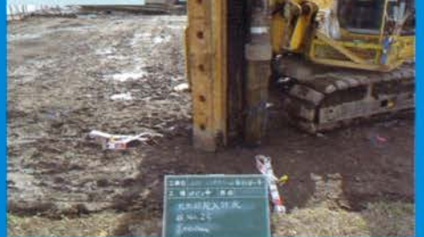
⑨ 打設完了レベル測定
