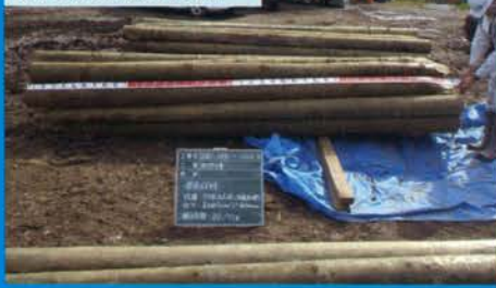
③ 丸太杭搬入計測
