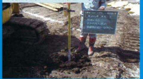
⑨ 打設完了レベル測定
